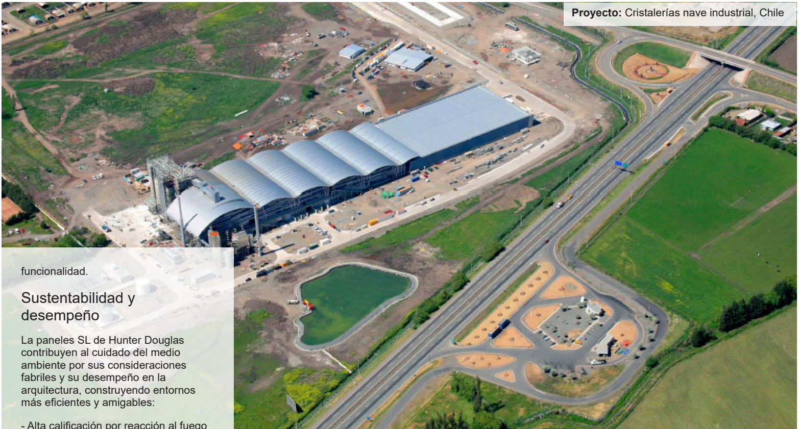
Proyecto: Cristalerías nave industrial, Chile
